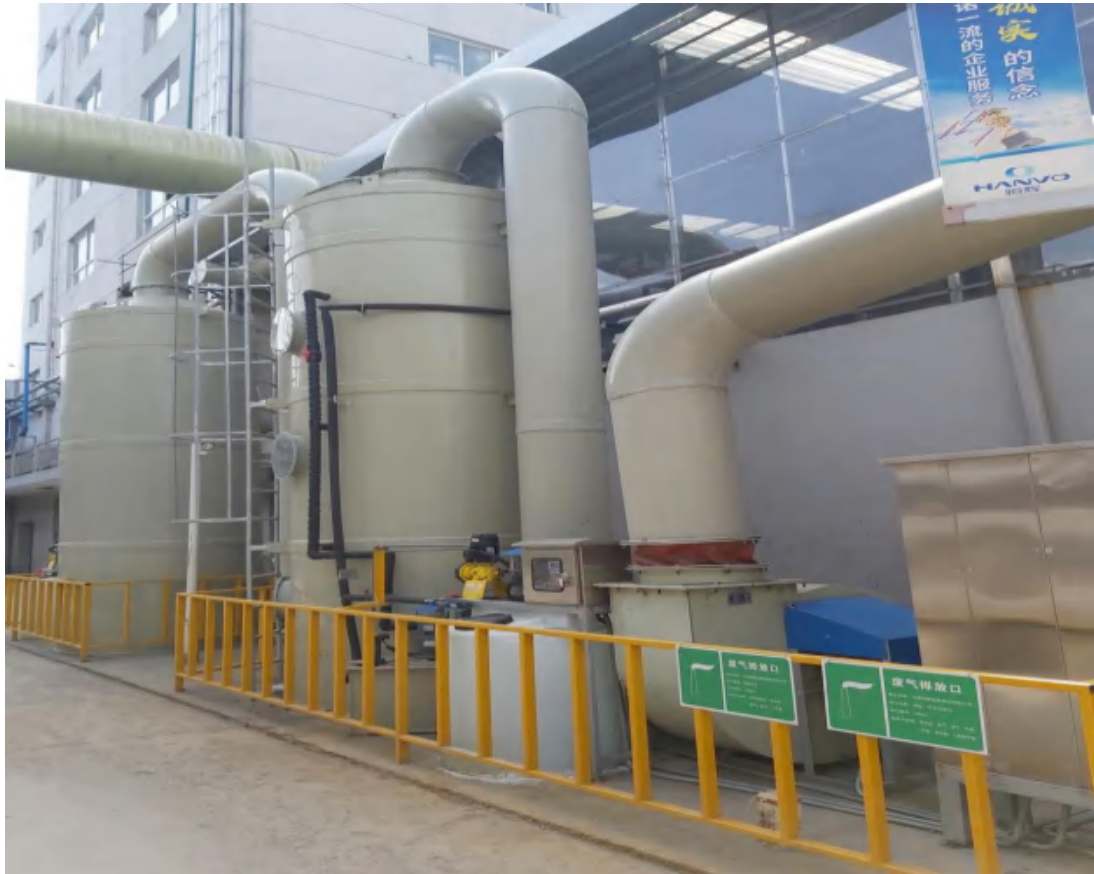
图 4-6 配料中心、污水站废气处理装置（二级碱喷淋+植物液除臭）现场图
