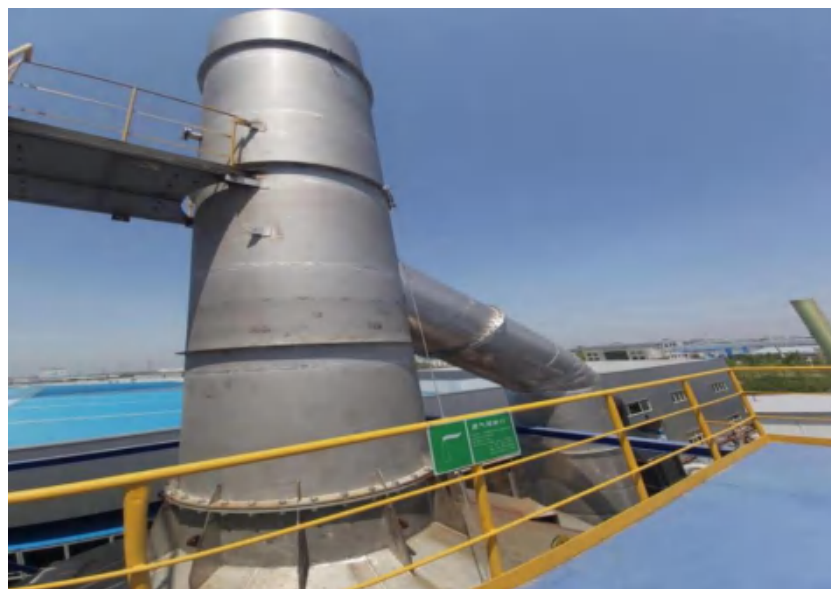
图 4-35 项目二、三、四车间 DA003#排气筒现状图
