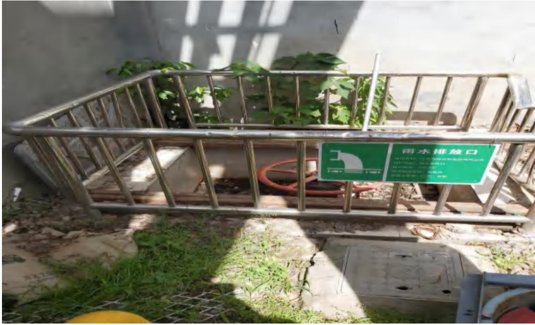
图 4-31 项目雨水排口及雨水排口切断阀门现状图
