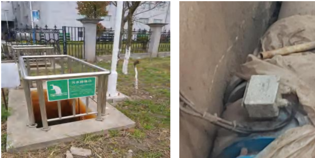
图 4-32 项目污水排口及污水排口切断阀门现状图
