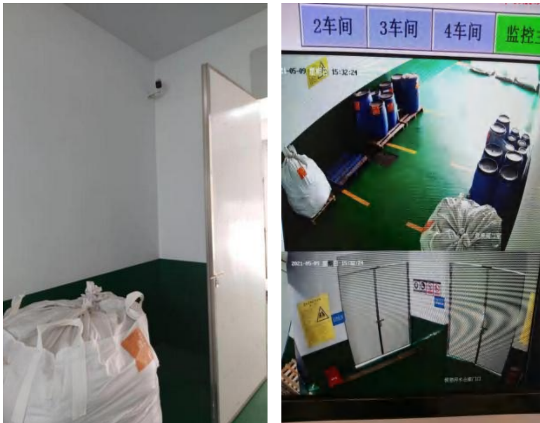
图 4-21 项目危废仓库摄像头、视频监控图
